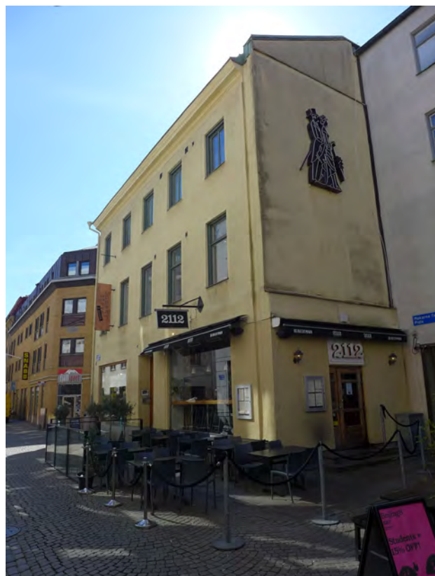
Fasad mot Magasinsgatan samt exponerad brandgavel.
