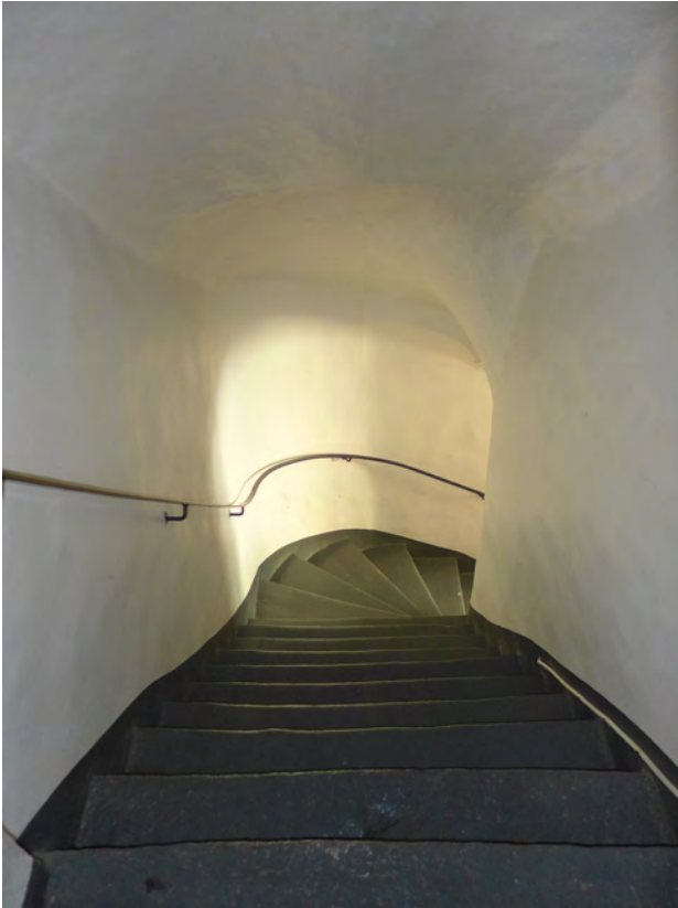
Ursprunglig trätrappa till vinden med bevarad ålderdomlig karaktär.
