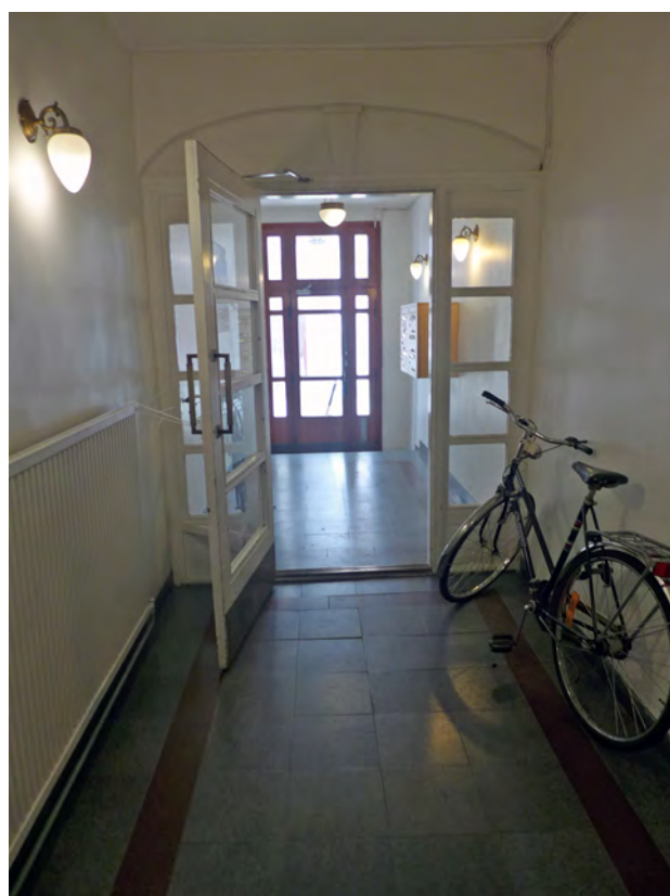
Den långsmala entréhallen med kalkstengolv från 1900-talets första hälft. Den välvda öppningen med klassicerande utformning är sannolikt ursprunglig, men dörrpartiet är sentida.
